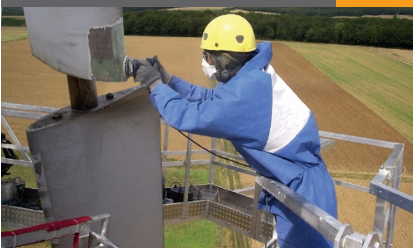
Reparatur vor Ort mit Hilfe einer speziellen Arbeitsbühne
